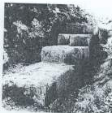
Figura 5 Il muro in loc. Gratte. Foto Sop.Etr. Mec.
