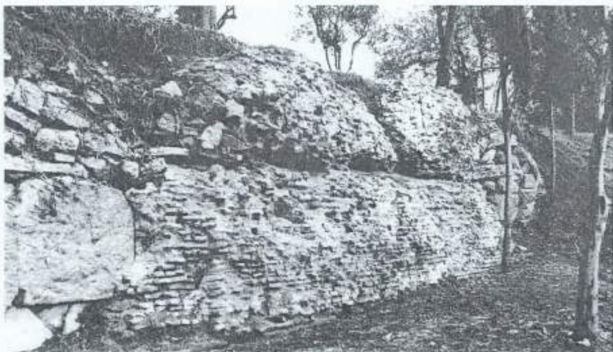
Figura 73 Resti dei muri ai lati della cavea: terrazza inferiore, foto Saam
