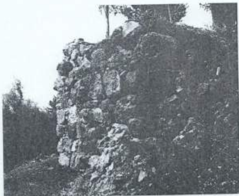
Figura 69 L'angolo nord-ovest in opera poligonale del grande basamento
