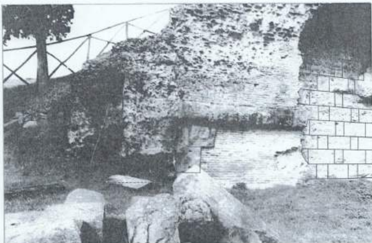
Figura 55 idem: blocchi di nenfro del lato orientale dell'accesso alla splanata, inglobati nel conglomerato cementizio e lato al di sotto dei laterizi e dei blocchi romani di pietra ignimbrite grigia: ricomposizione del muro in opera a scacchiera, secondo le impronte dai blocchi nel conglomerato cementizio romano
